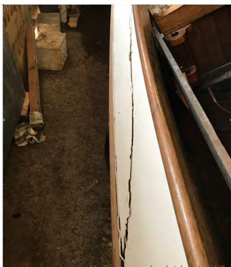
La fissure sur le plat-bord et hiloire
